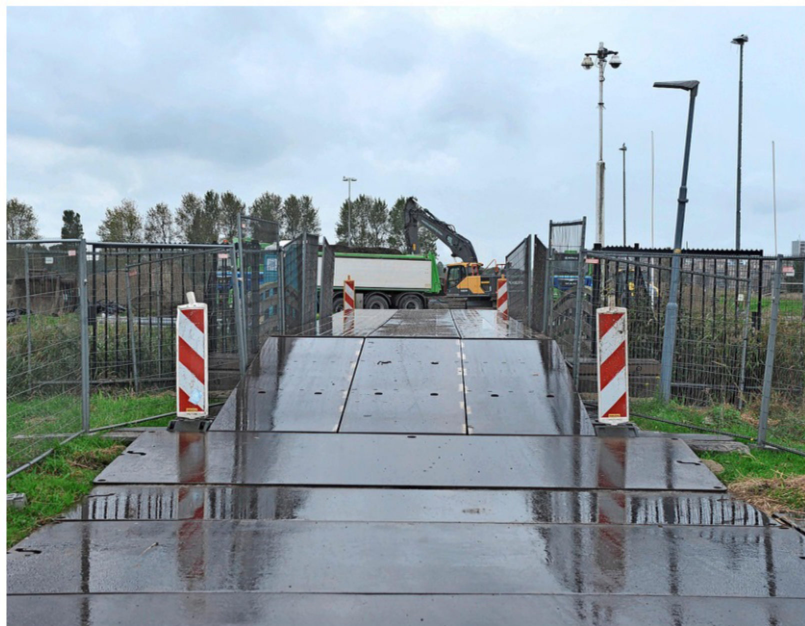
De noodbrug die bestand is tegen het zware materieel dat bij de aanleg van de skeelerbaan nodig is.
